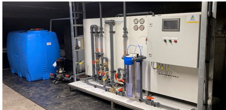
➔ Filtre RO – réduction de conductivité d'eau pour la chaudière
