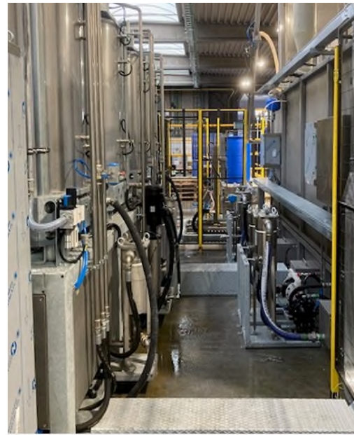
➔ Filtre RO – réduction de conductivité d'eau pour la chaudière
